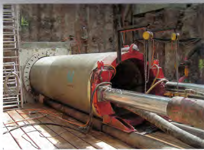
Vortriebprojekt „Enzdüker“ in Pforzheim durch die Firma Sonntag Baugesellschaft mbH & Co. KG mit Vortriebsrohren DA1720. Foto: Hobas
