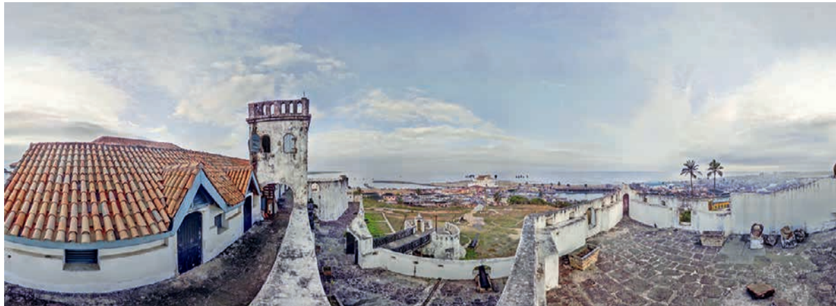
Von den Prachtbauten an der Küste Ghanas lieferte der IMAGER 5010C Scans und HDR-Panoramen.
